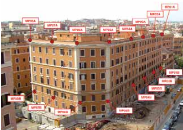
Esempio di prodotto che documenta il punto di installazione dei sensori
